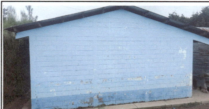
Foto 3: Pintura interior de todas las aulas, módulos de baños y bodegas.
